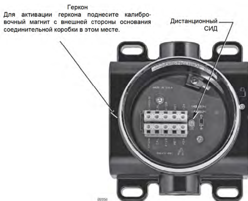
Рис. 17. Расположение клеммных контактов и геркона в соединительной коробке PIRTB.
